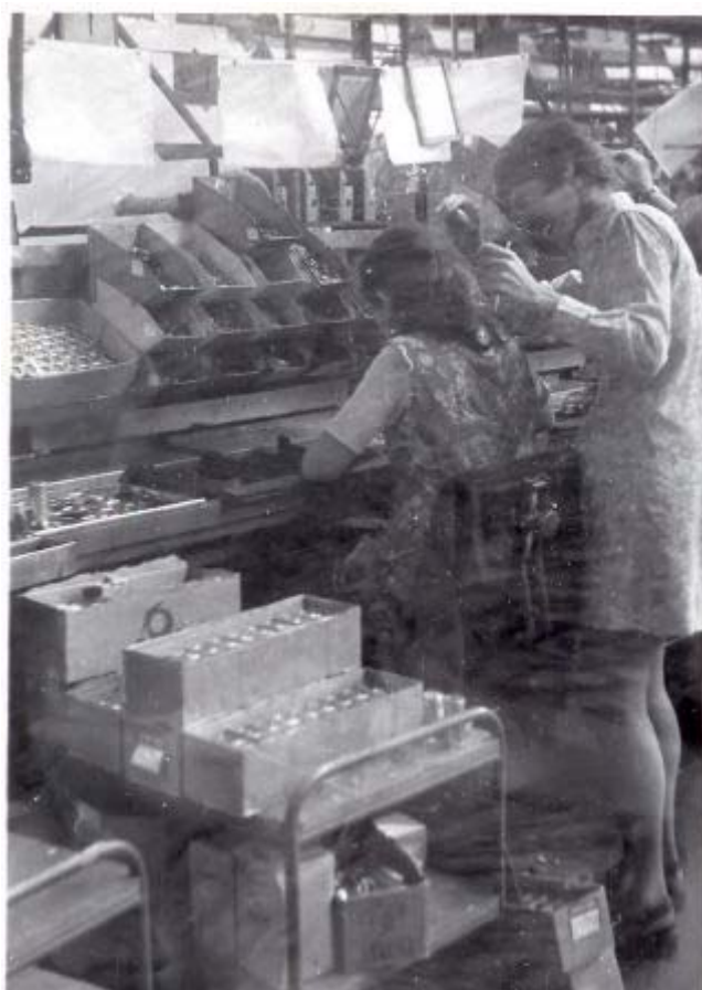
Figure 3. Enregistrement de l'électromyographie des muscles de la nuque d'une ouvrière de la chaîne de montage électronique (Pose des électrodes par Catherine Teiger, d'après Laville, Teiger, Duraffourg, 1972)
